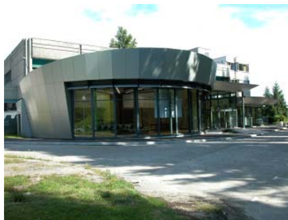
Les locaux du LGGE aujourd'hui.
